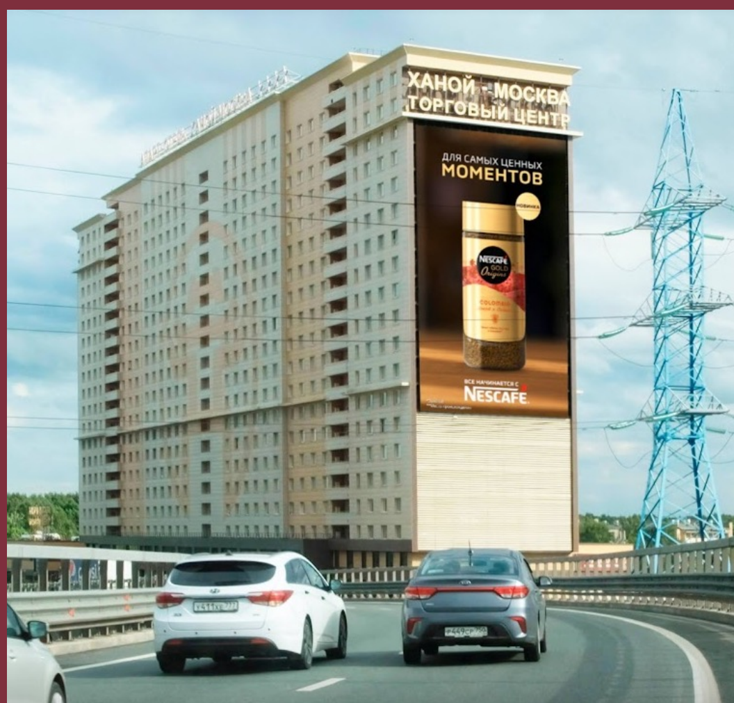
ФАСАД НА ПЕРЕСЕЧЕНИИ МКАД И ЯРОСЛАВСКОГО Ш.
